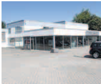
Das leer stehende Autohaus an der B 5 soll dem Erdboden gleich gemacht werden.
