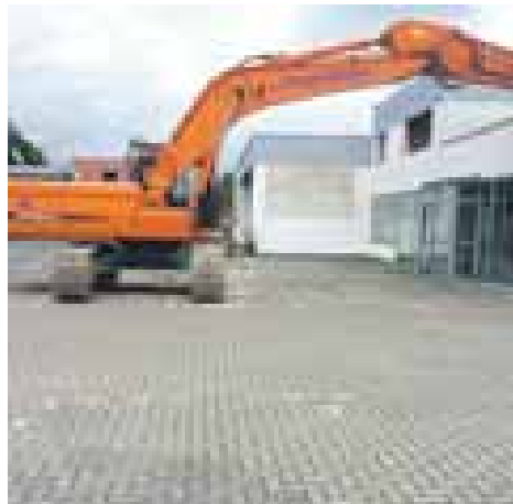
Die Bagger rollen bereits auf dem ehemaligen Travag-Gelände.
