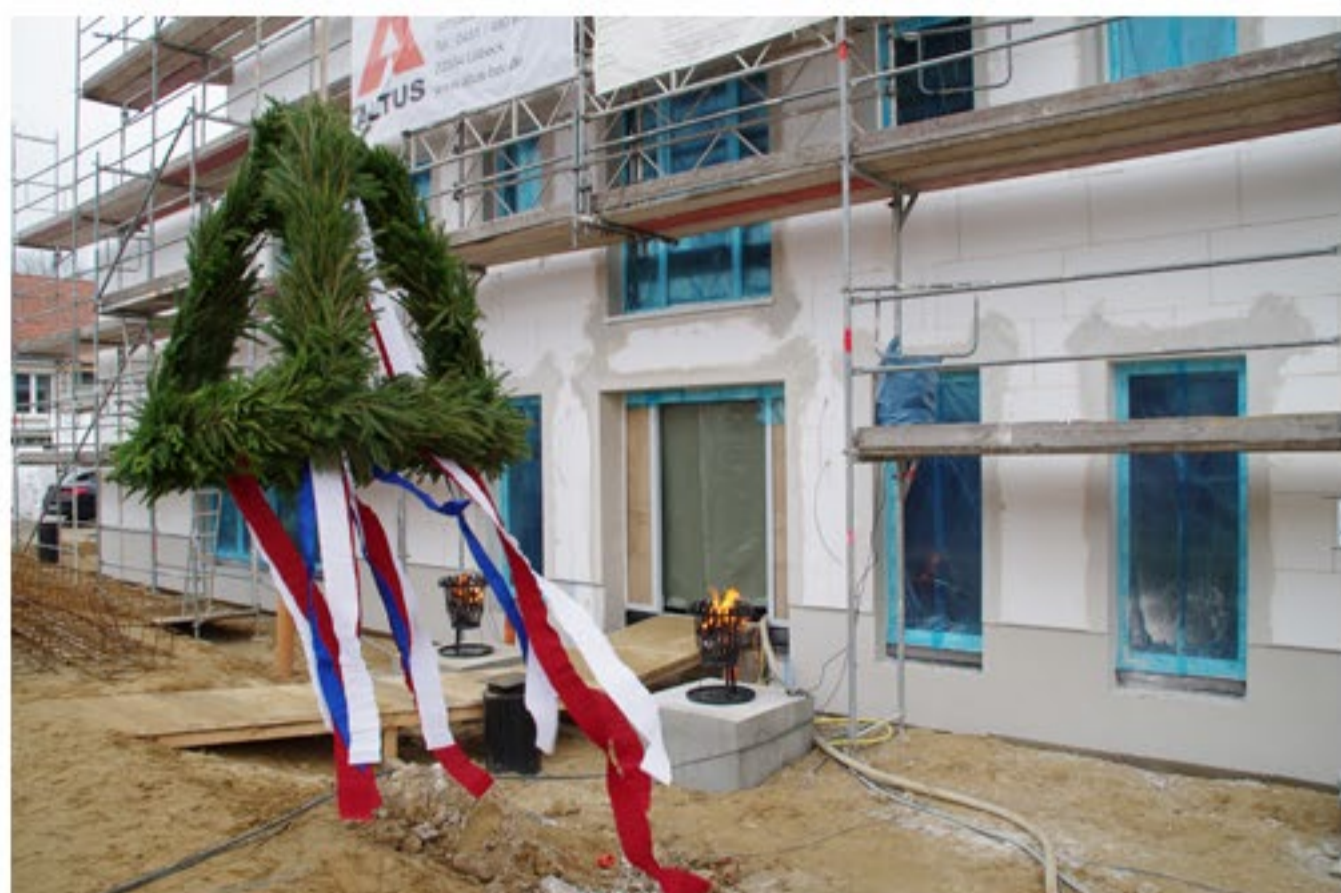
Heute wurde mit zahlreichen Gästen aus Wirtschaft, Politik und Verwaltung das Richtfest der neuen Seniorenwohnanlage am Glüsinger Weg gefeiert. Foto: W. Reichenbächer
